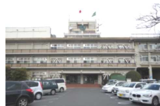
(現在の市役所南棟)
