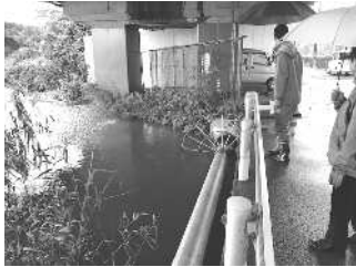
◀浸水の心配される箇所を巡回
