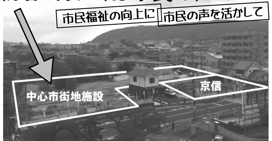
市役所屋上から見た開田保育所あと地
