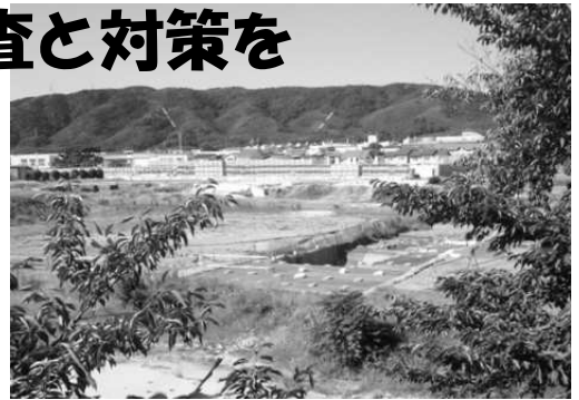
工事中の立命館建設予定地
