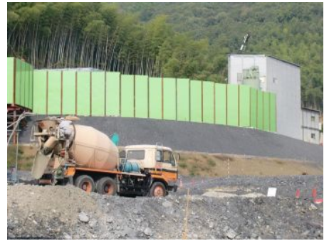
西代地域。防音壁の奥では掘削工事。
