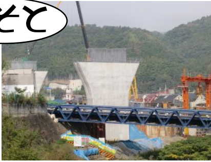
高台一丁目辺り高架橋工事。
